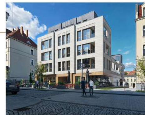
Widok budynku od strony ul. Kościelnej
