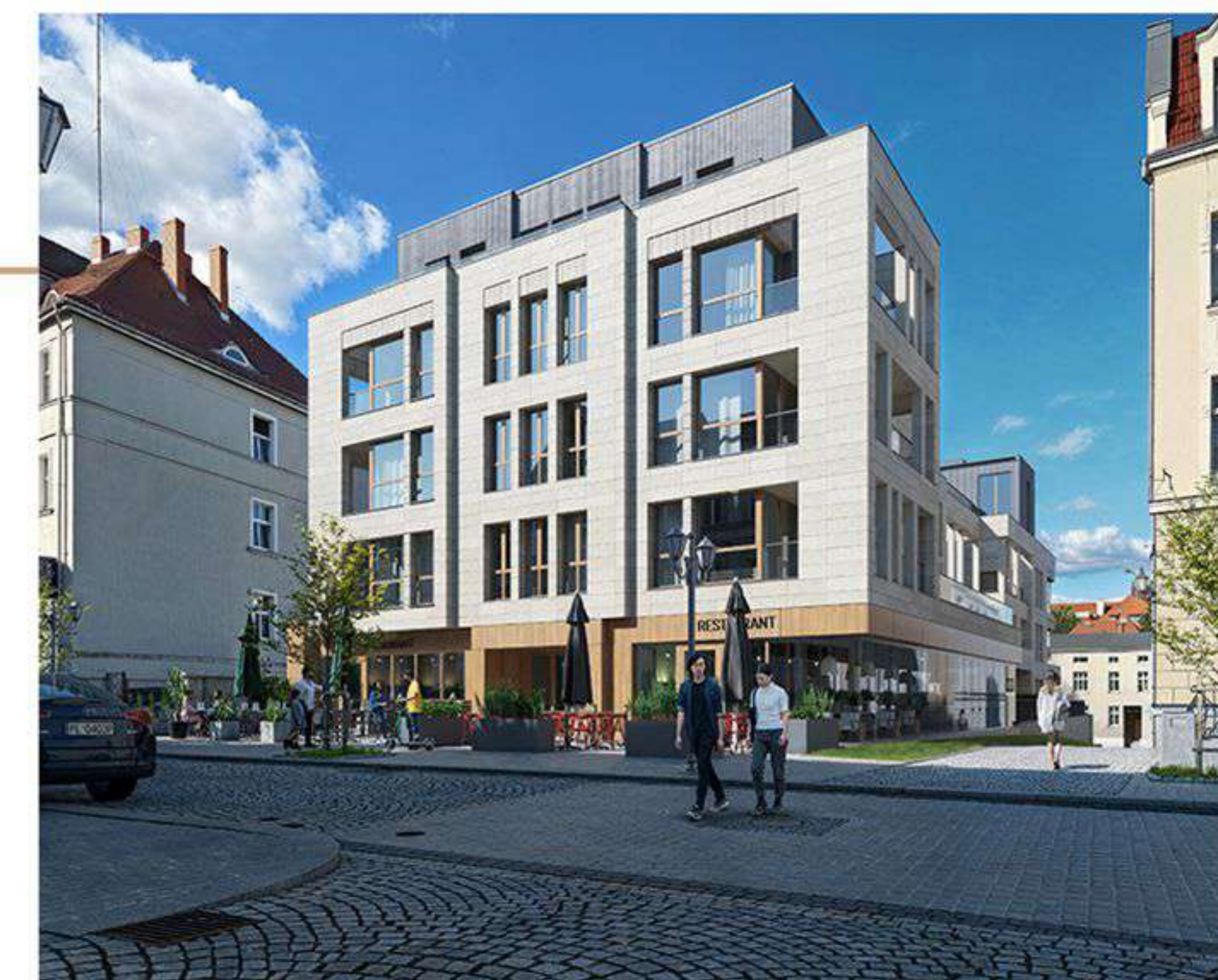
Widok budynku od strony ul. Kościelnej
