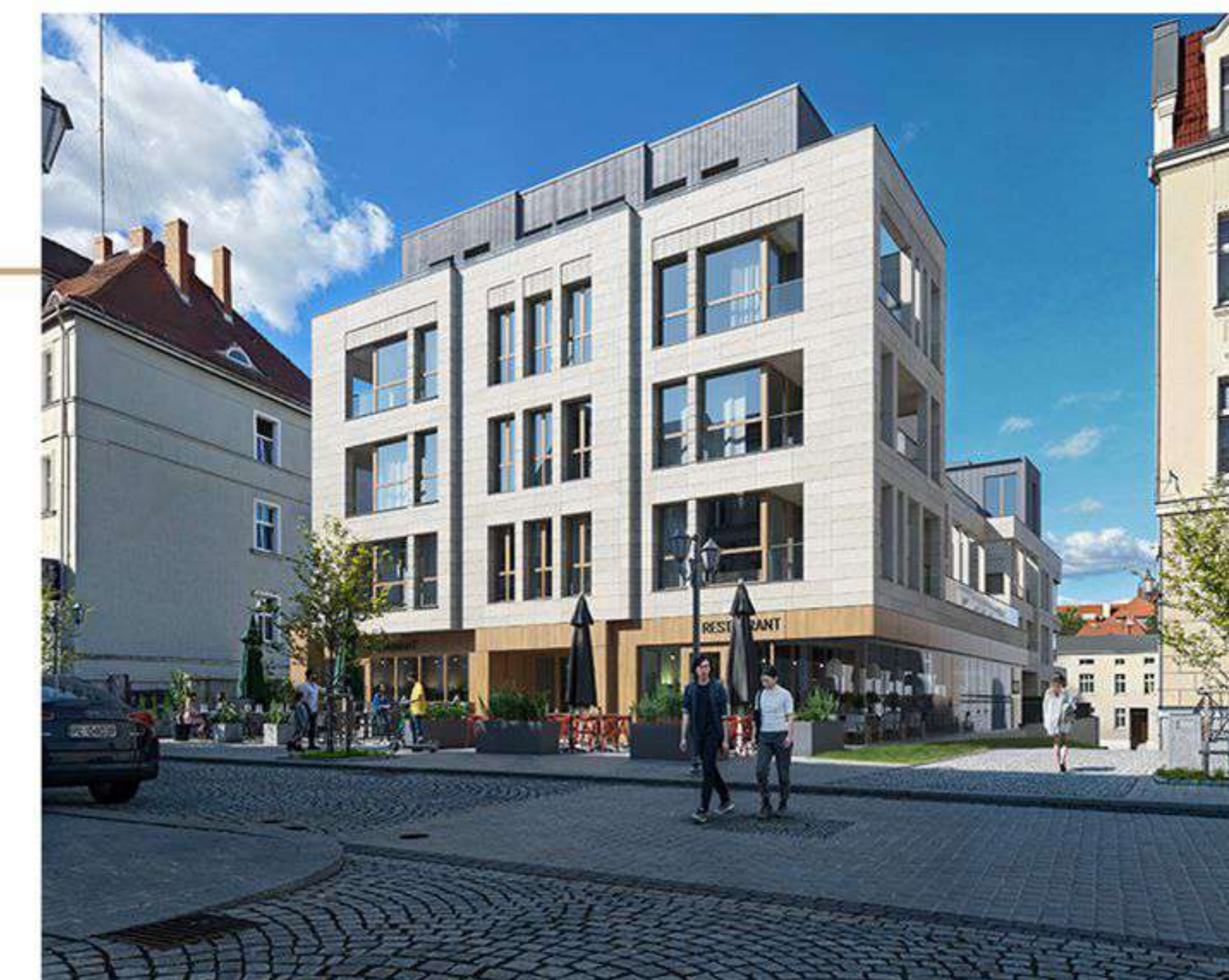
Widok budynku od strony ul. Kościelnej
