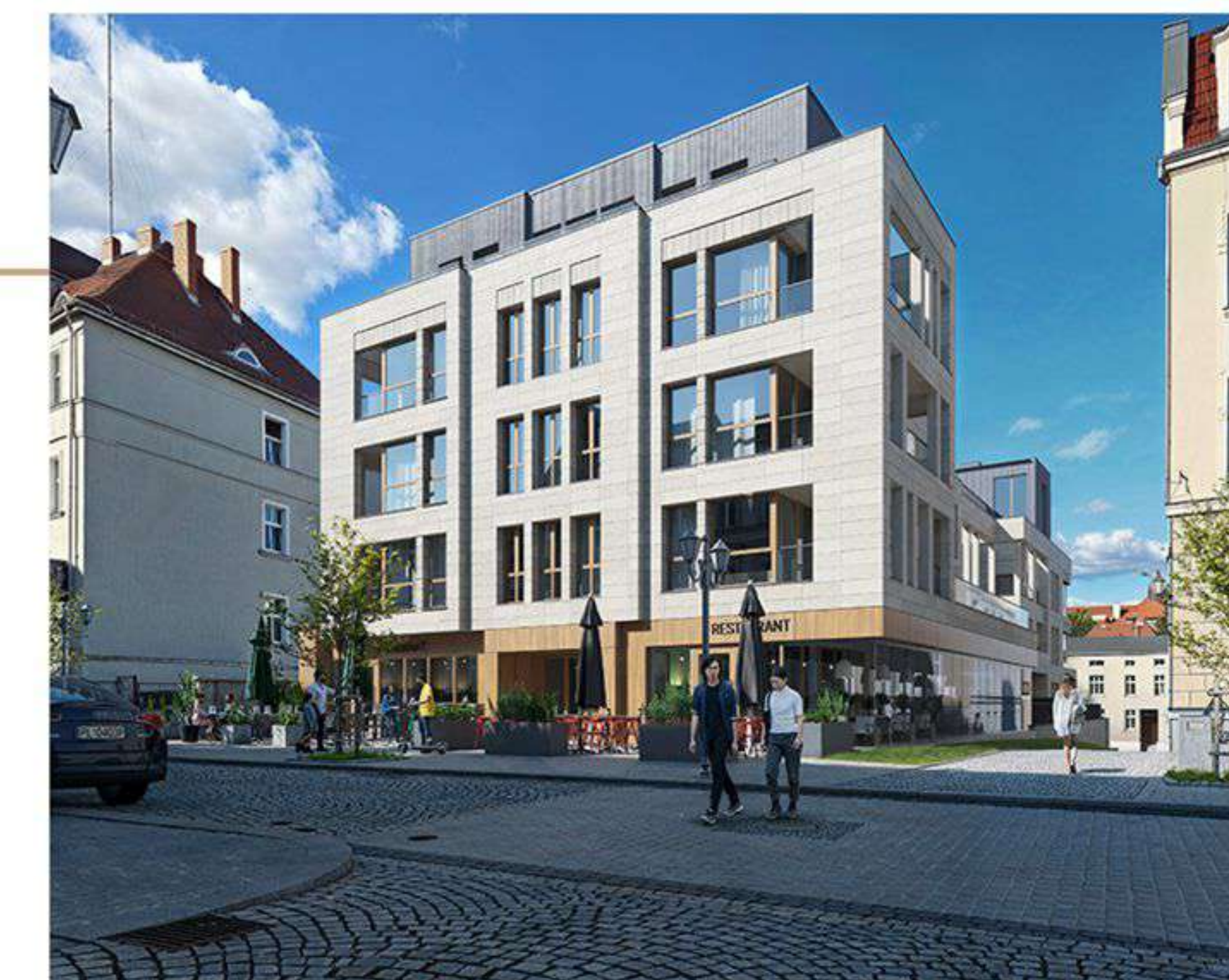
Widok budynku od strony ul. Kościelnej
