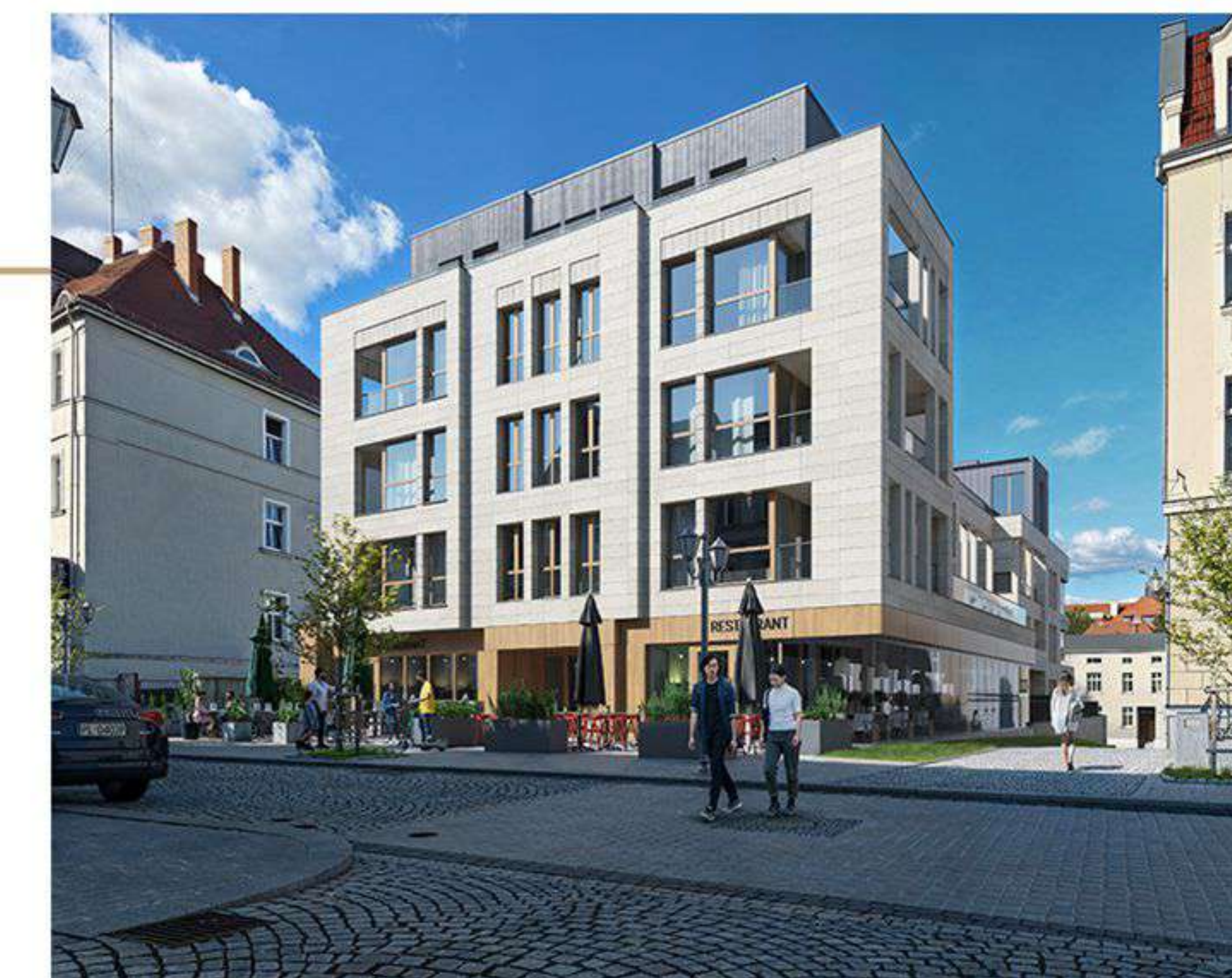
Widok budynku od strony ul. Kościelnej
