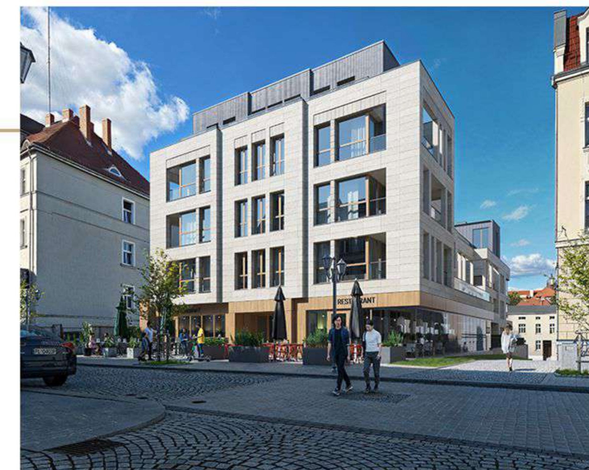
Widok budynku od strony ul. Kościelnej
