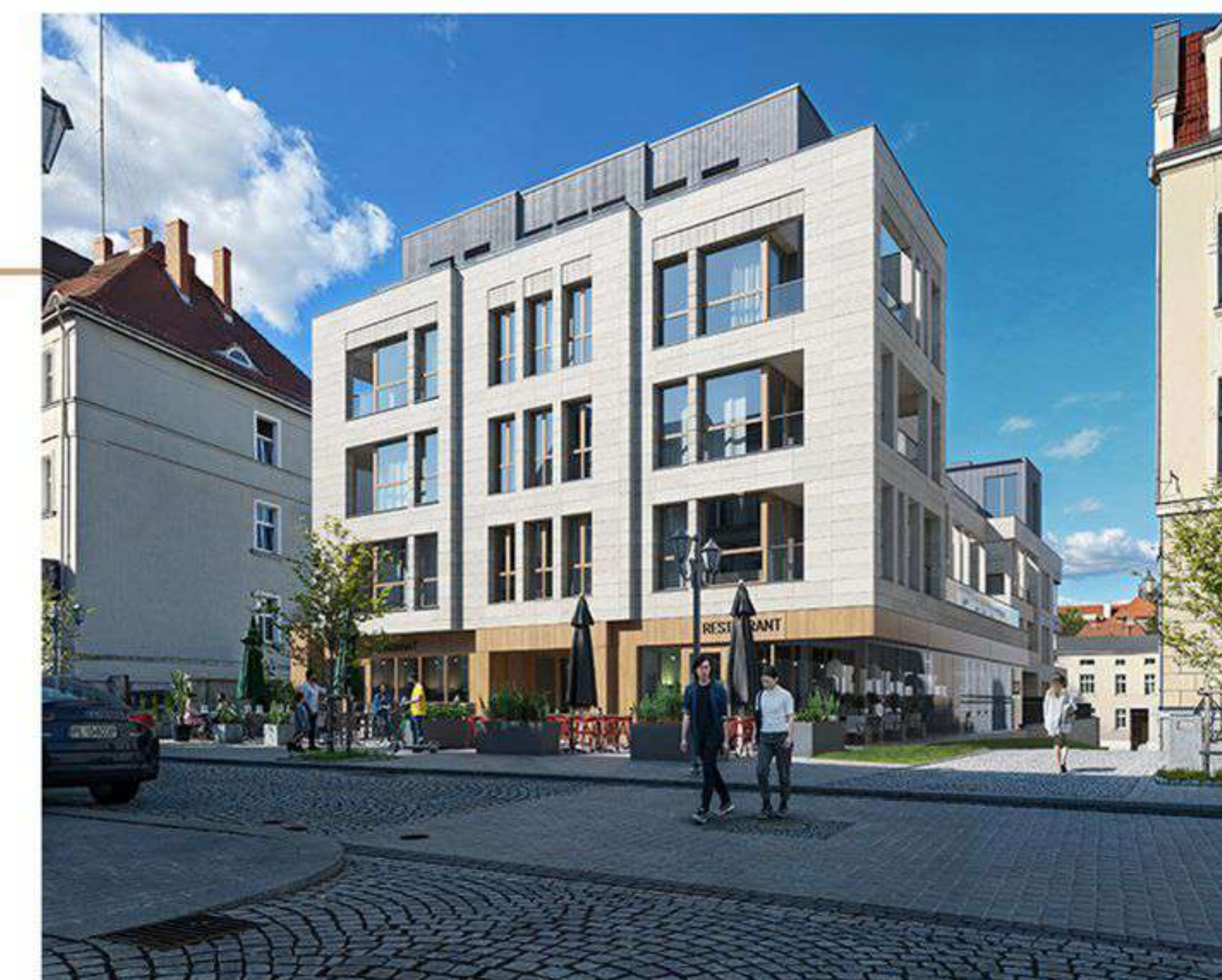
Widok budynku od strony ul. Kościelnej
