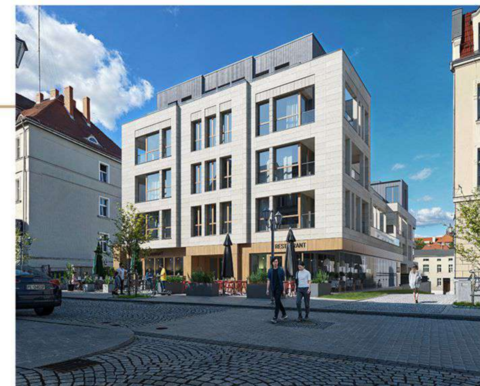
Widok budynku od strony ul. Kościelnej
