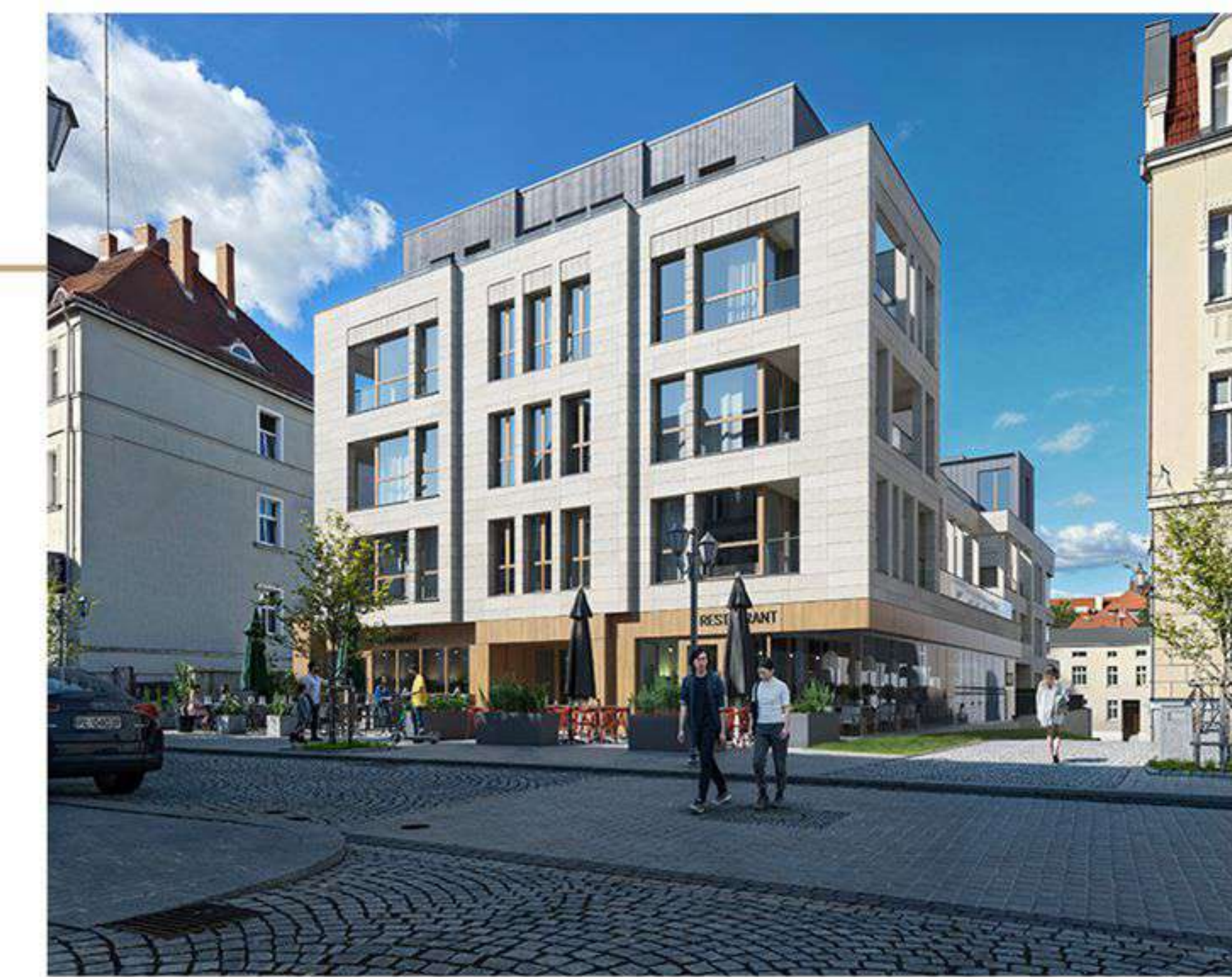
Widok budynku od strony ul. Kościelnej
