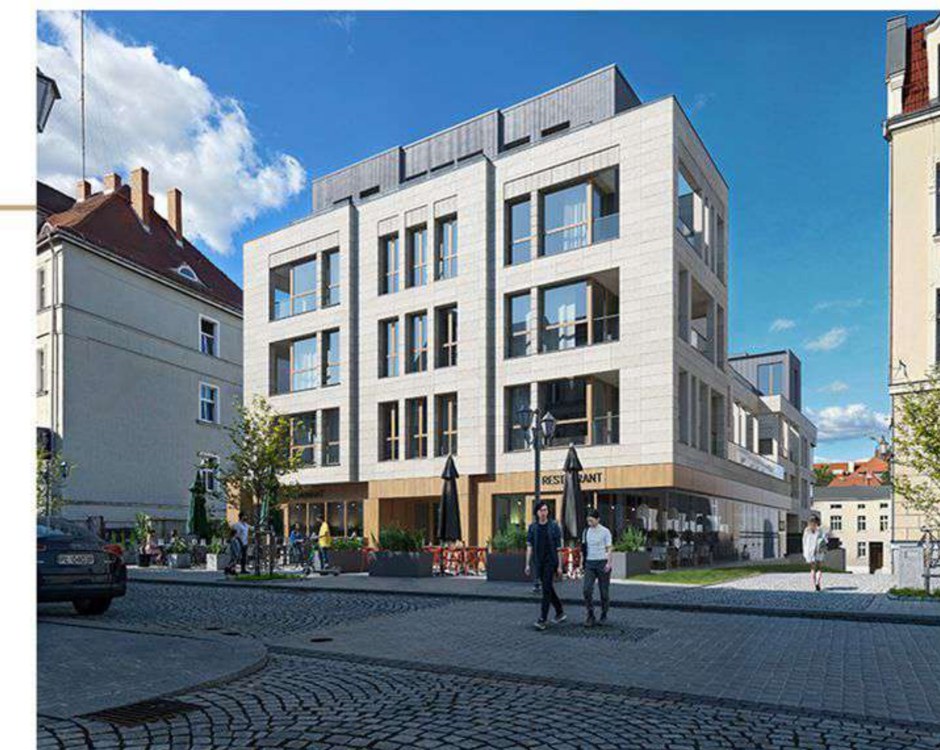
Widok budynku od strony ul. Kościelnej
