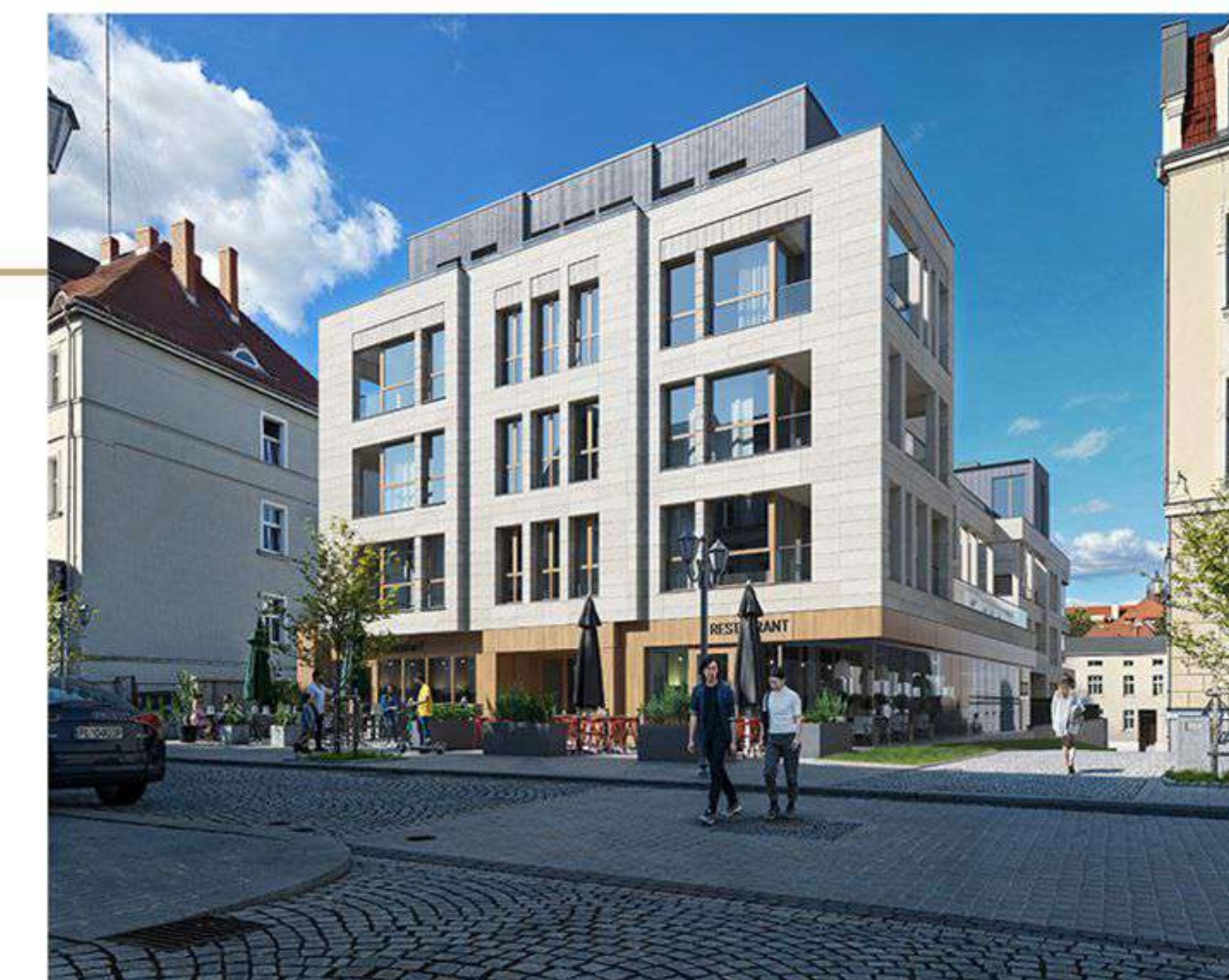
Widok budynku od strony ul. Kościelnej
