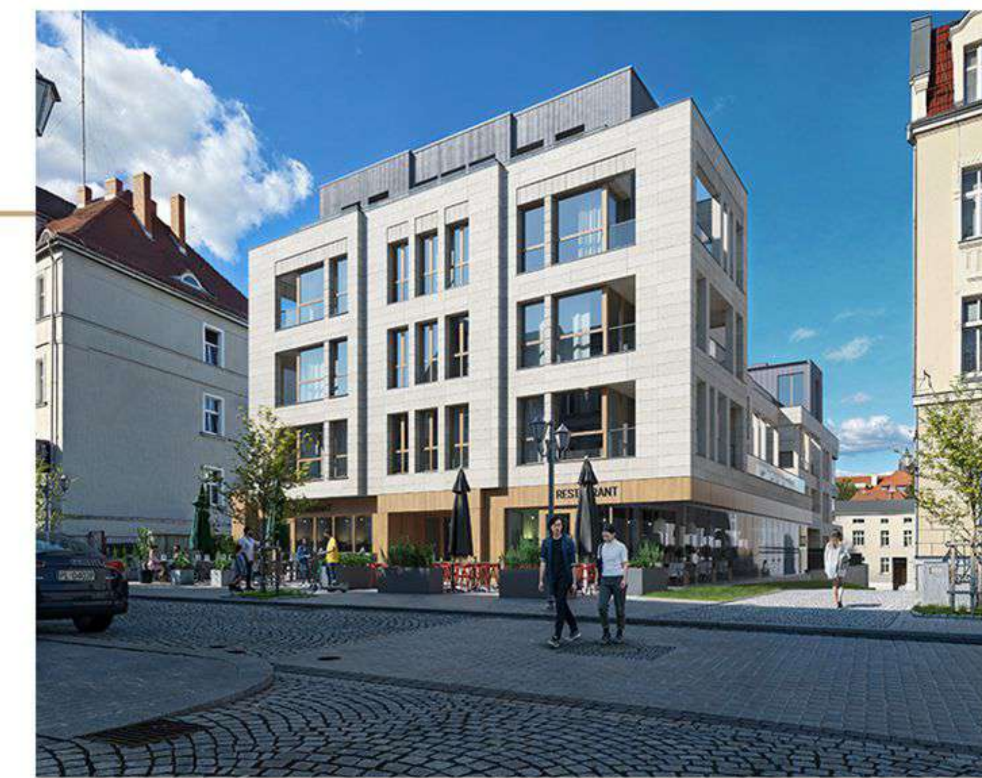
Widok budynku od strony ul. Kościelnej
