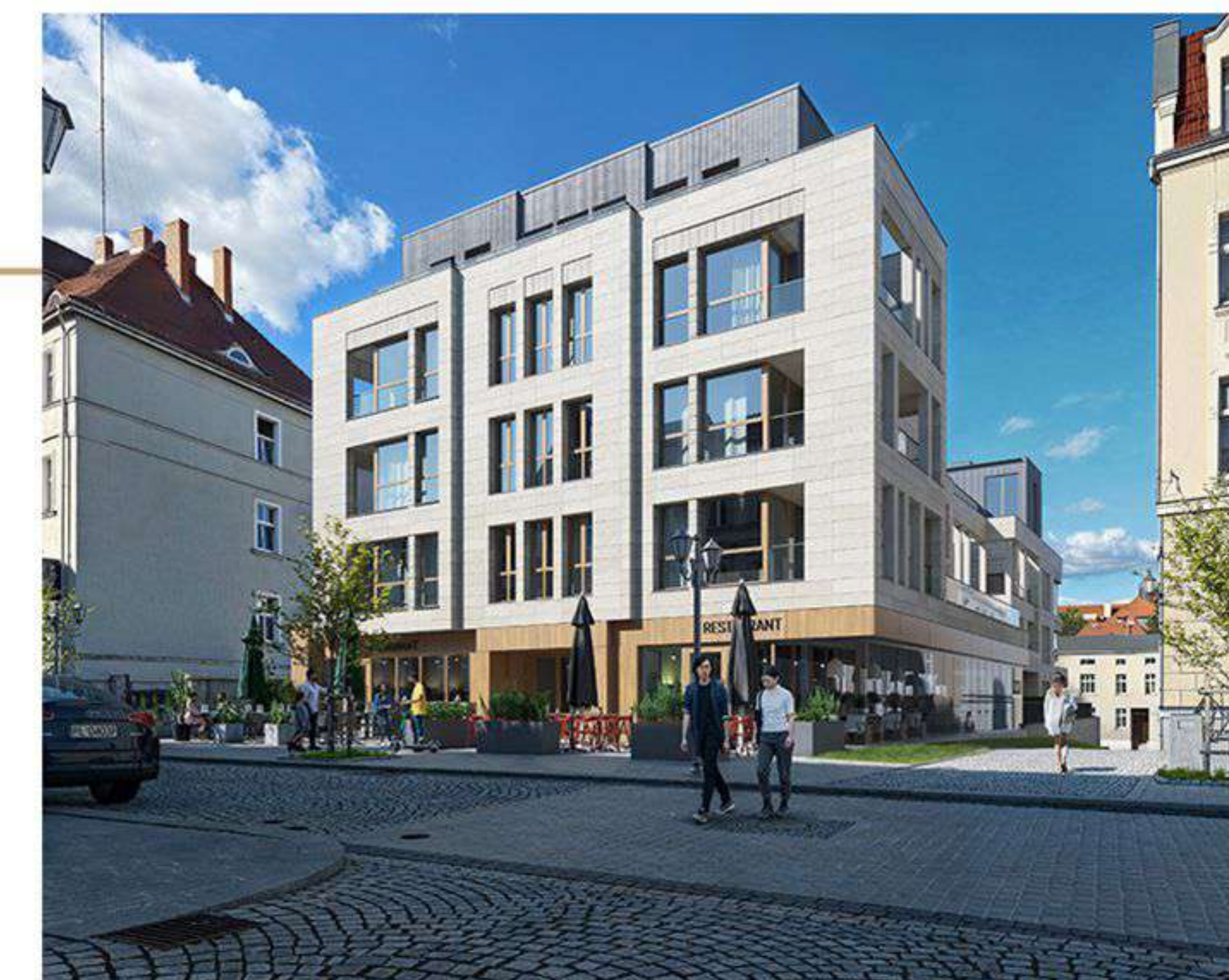
Widok budynku od strony ul. Kościelnej
