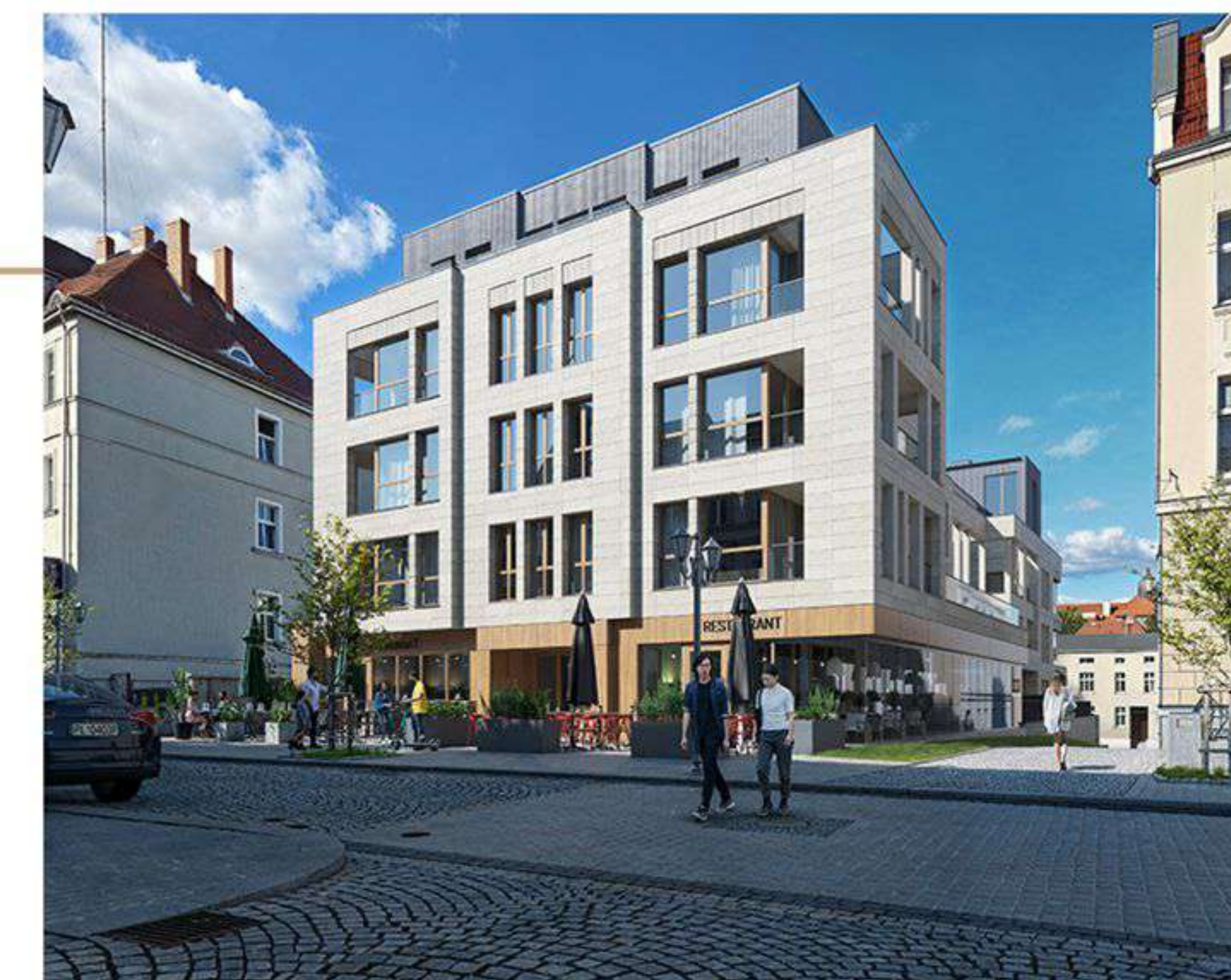
Widok budynku od strony ul. Kościelnej
