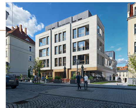
Widok budynku od strony ul. Kościelnej
