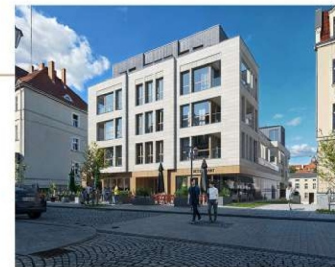
Widok budynku od strony ul. Kościelnej
