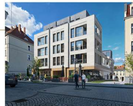
Widok budynku od strony ul. Kościelnej
