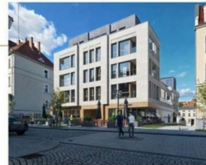
Widok budynku od strony ul. Kościelnej
