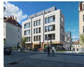
Widok budynku od strony ul. Kościelnej
