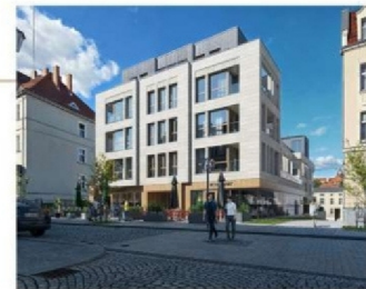
Widok budynku od strony ul. Kościelnej
