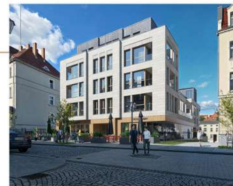
Widok budynku od strony ul. Kościelnej
