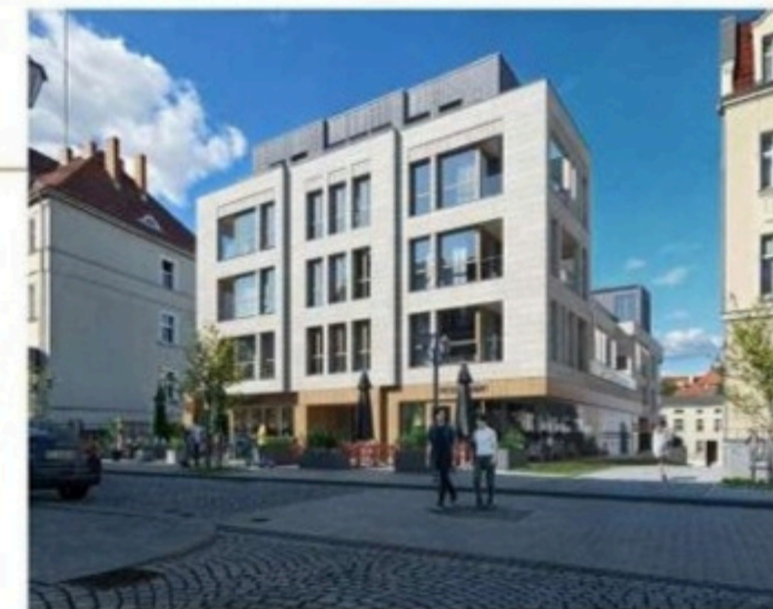
Widok budynku od strony ul. Kościelnej
