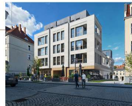
Widok budynku od strony ul. Kościelnej
