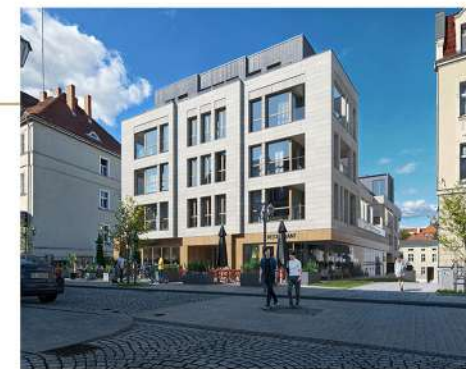
Widok budynku od storny ul. Kościelnej
