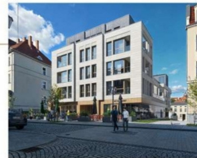
Widok budynku od strony ul. Kościelnej
