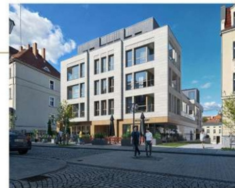
Widok budynku od strony ul. Kościelnej
