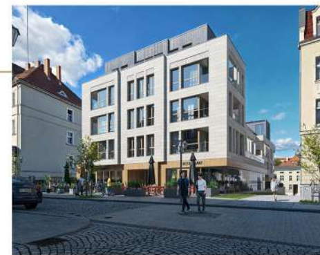
Widok budynku od strony ul. Kościelnej
