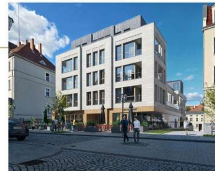
Widok budynku od strony ul. Kościelnej
