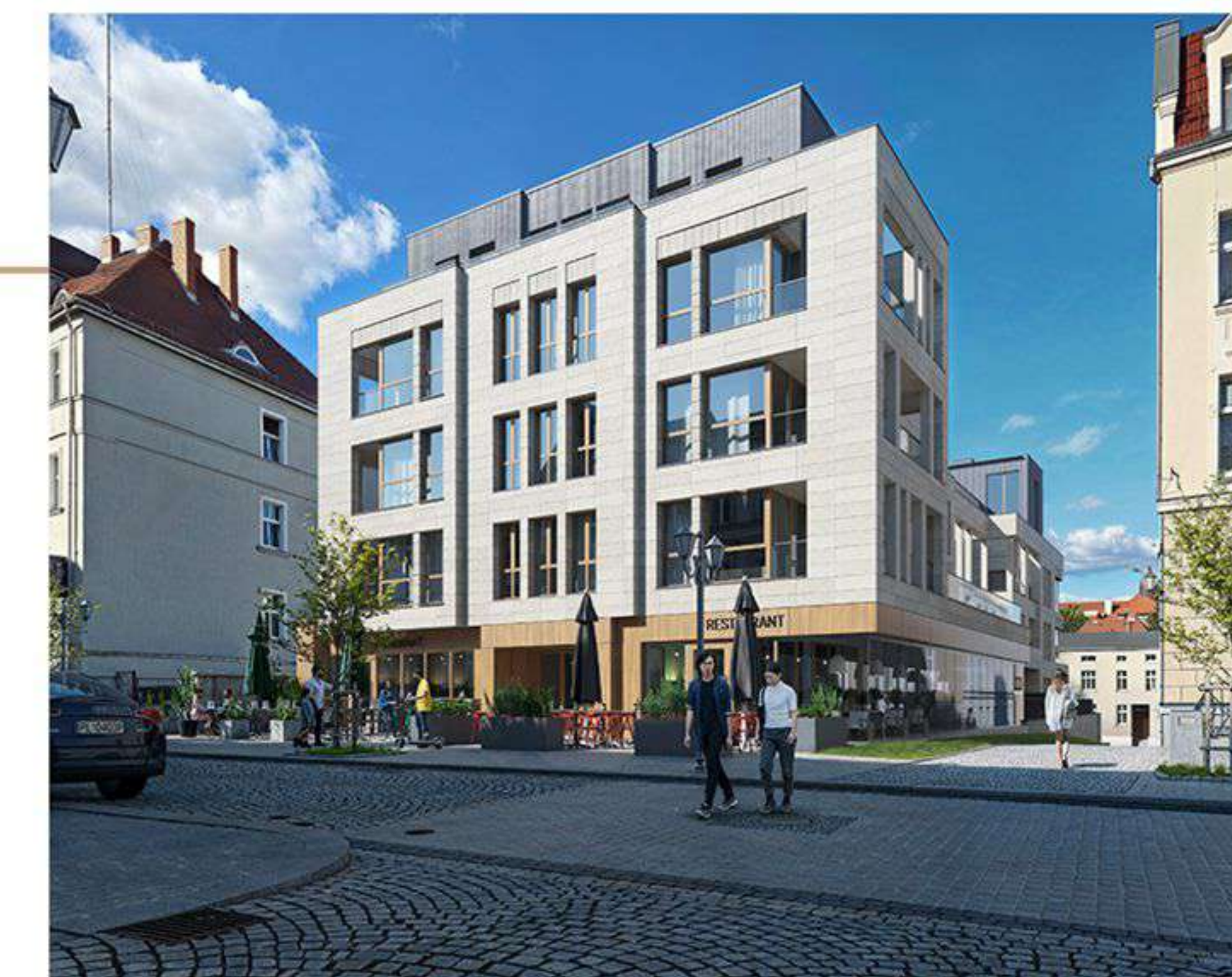
Widok budynku od strony ul. Kościelnej
