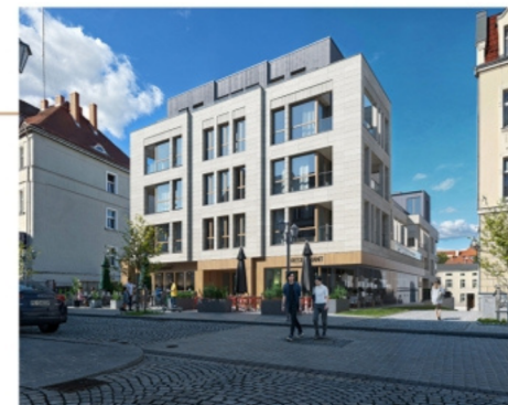
Widok budynku od strony ul. Kościelnej
