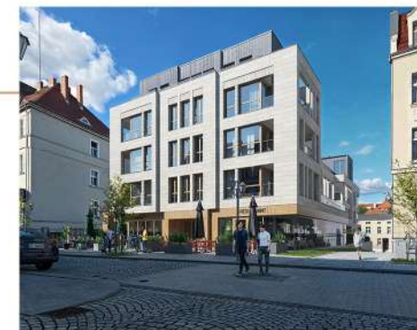
Widok budynku od strony ul. Kościelnej
