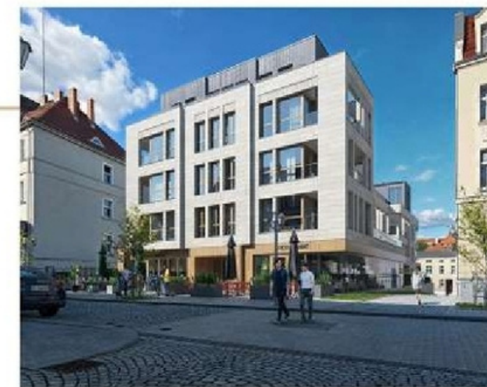
Widok budynku od strony ul. Kościelnej
