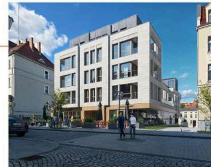
Widok budynku od strony ul. Kościelnej
