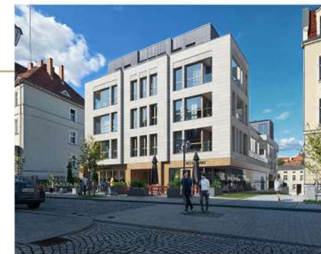
Widok budynku od strony ul. Kościelnej
