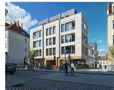
Widok budynku od strony ul. Kościelnej
