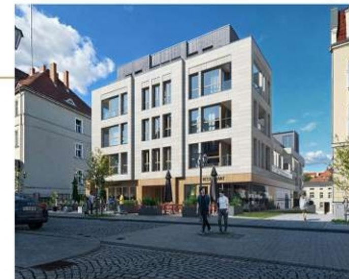
Widok budynku od strony ul. Kościelnej
