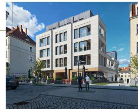
Widok budynku od strony ul. Kościelnej
