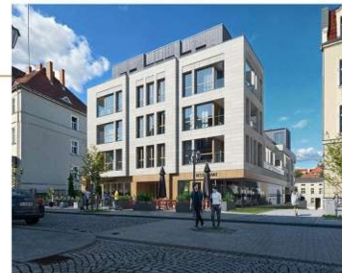
Widok budynku od strony ul. Kościelnej
