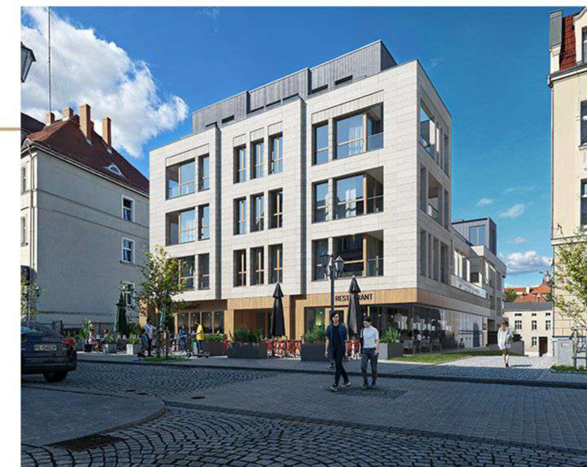
Widok budynku od strony ul. Kościelnej
