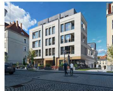
Widok budynku od strony ul. Kościelnej
