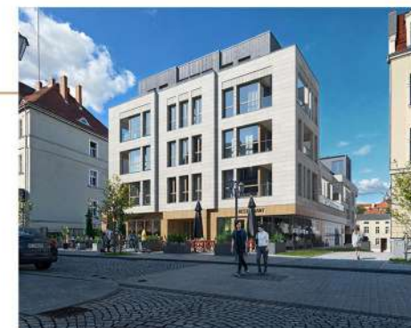
Widok budynku od strony ul. Kościelnej
