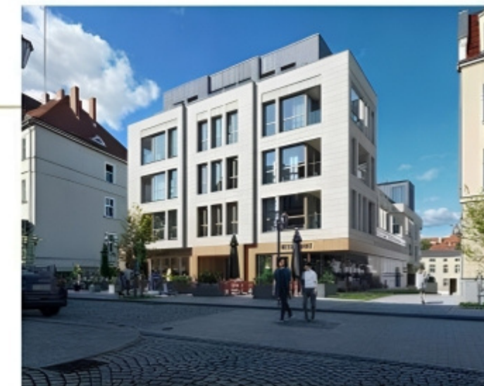
Widok budynku od strony ul. Kościelnej
