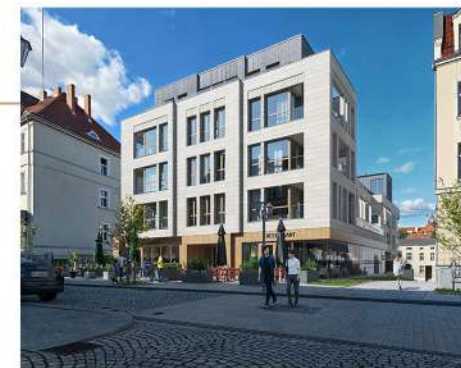
Widok budynku od strony ul. Kościelnej
